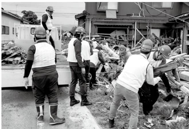
がれき等の撤去作業
